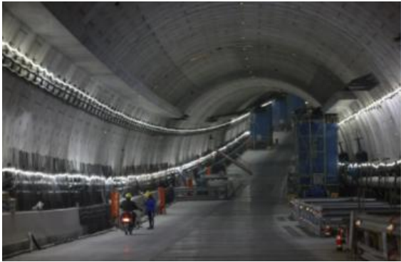
应用一：隧道工程
