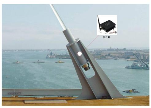
对于钢制拉索声发射传感器布置的距离不宜超过 5 米; 对于新兴的碳纤维及高分子材料 拉索, 传感器的布置距离需要事先通过实验进行计算。
