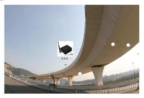
另外混凝土桥梁的桥墩与桥面连接位置由于受力较大,也是容易发生破坏的地方。检测 此位置时传感器应在距离接缝位置 1 米处布置,接缝上下各一排。
